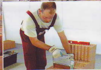
System murowania na ciekłą spoinę
