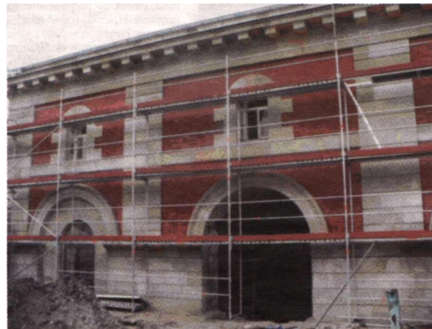
Brama Szczepieszka po odsłonięciu elewacji budynku
