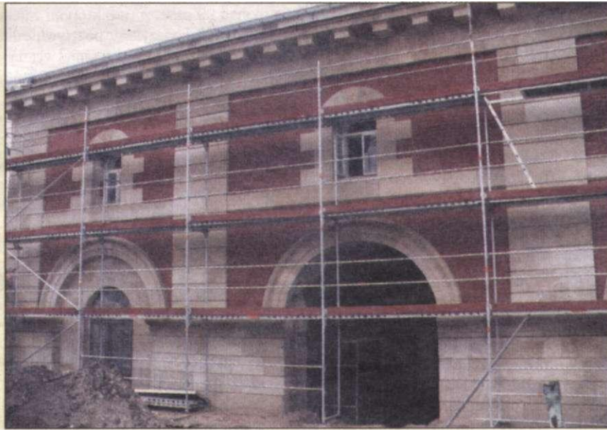
Brama Szczepieszka po odsłonięciu elewacji budynku.
