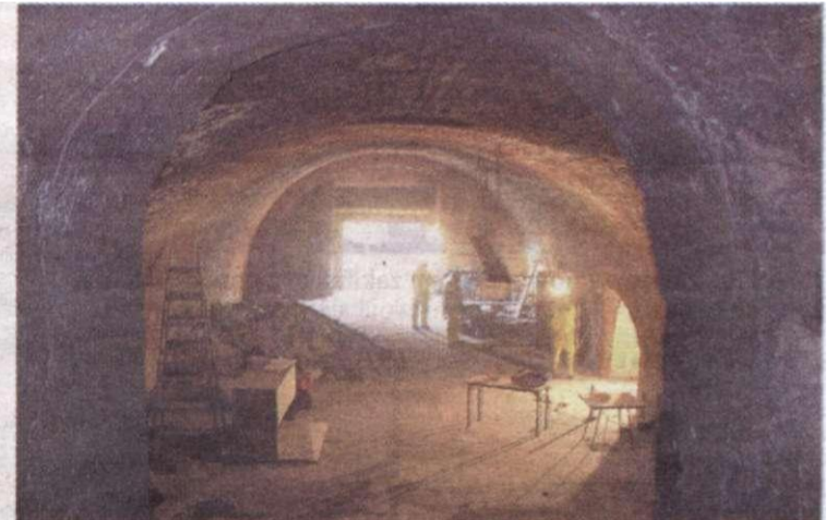
Prace w rozbiórkowe w Kazamacie Bastionu I.
