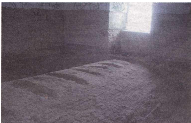
Brama Szczepieska - odkrycie od góry stropu ceglano-kolebkowego.
